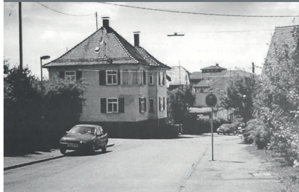
Pestalozzistraße 7 (bis 1976: Schillerstraße 7) Bau: 1930er Jahre / Abriss: 1998
